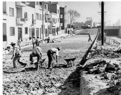
Construcción del Viaducto y Periférico
