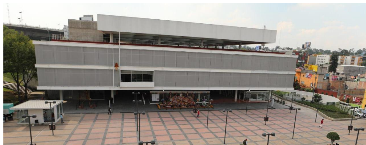
Término de construcción del Nuevo Edificio de la Alcaldía, con nueva área de Centro de Atención Ciudadana en planta baja
